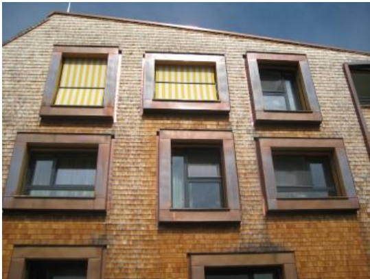
Material mit Bezug zum Ort: Fassade des NÖ Pflege- und Betreuungszentrums Türrnitz
